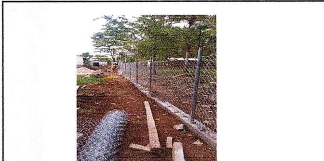
Foto 4: Colocación de malla del muro perimetral
